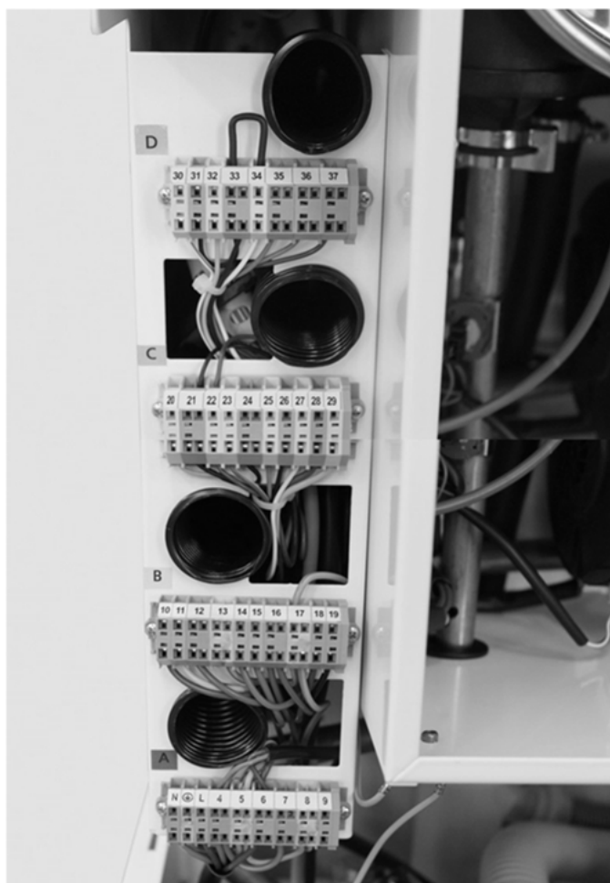
Abb. 18: Elektrische Anschlussklemmen ProCon E...
