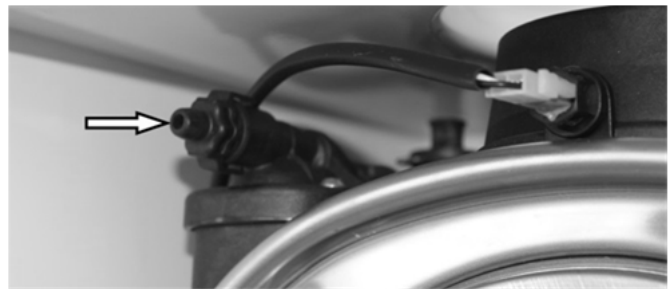
Abb. 29: Kesselkörper-Entlüfter
