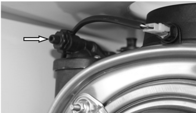
Abb. 24: Kesselkörper-Entlüfter
