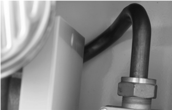
Abb. 34: Richtige Einbauposition des Gasrohres am Gas-Luft-Mischkasten
