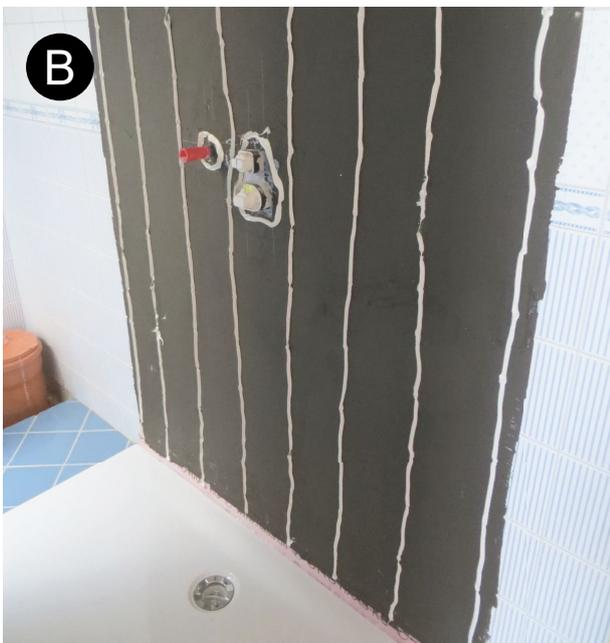
Power-Montagekleber im Abstand von 20 cm mit der V-Spitze in durchgehenden Bahnen auf die Wand auftragen. Vom Rand ist ein Abstand von 5 cm einzuhalten.
