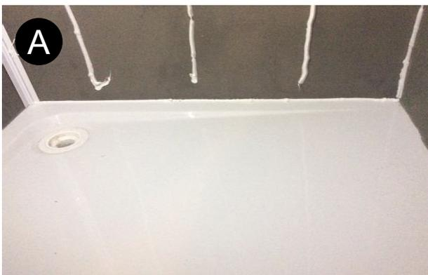
Entlang des Tassenrandes eine Raupe universelle Sanitär-Dichtmasse ziehen, damit die Platten am Boden versiegelt sind.
